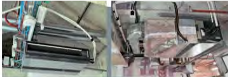
LAVORI IN CORSO. Installazione delle unità canalizzate a soffitto a servizio degli uffici dal primo al quinto piano
